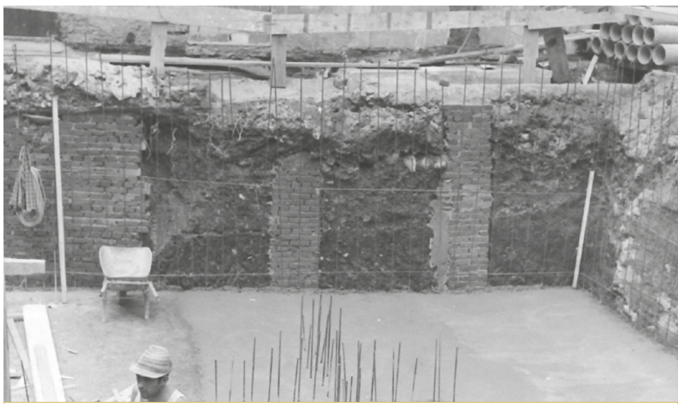
Foto dei lavori di ristrutturazione
